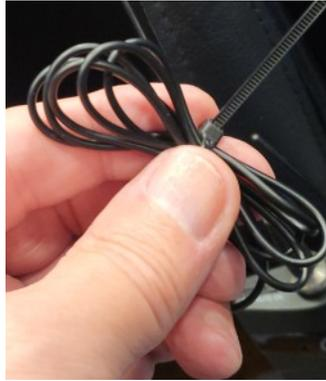
Überschüssige Länge des Kabels zusammenbinden.
